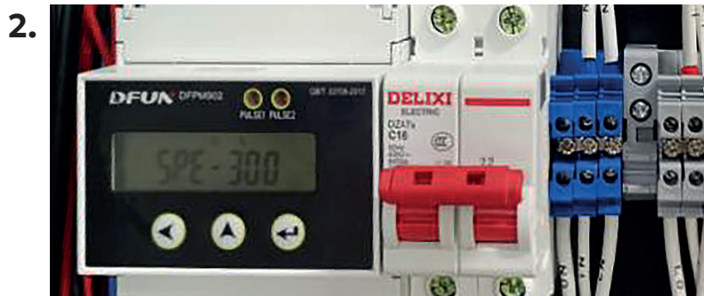
Промежуточный автоматический выключатель – в положение «ВКЛ»
