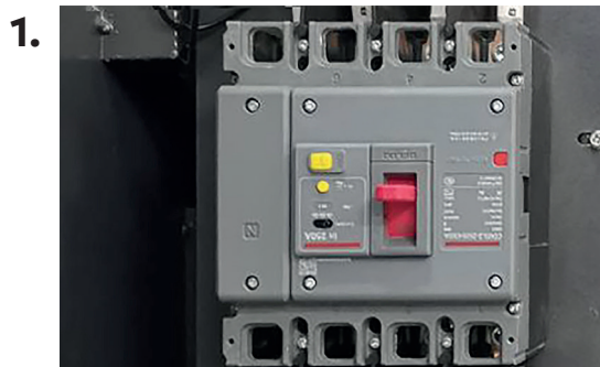
Автоматический выключатель внизу – в положение «ВКЛ»
